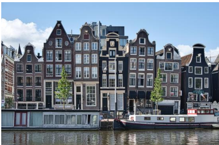
Häuserfassade in Amsterdam
