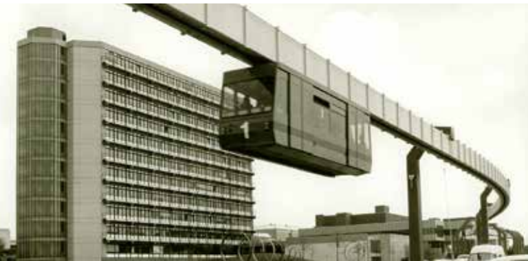
1985: H-Bahn auf dem Dortmunder Universitätsgelände
