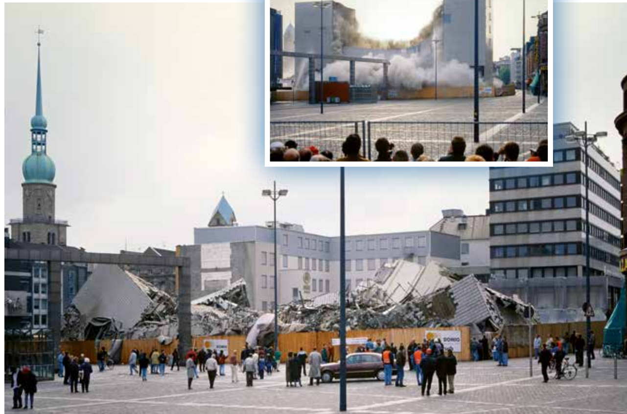
Die Sprengung der Stadt- und Landesbibliothek 1996 in Dortmund
